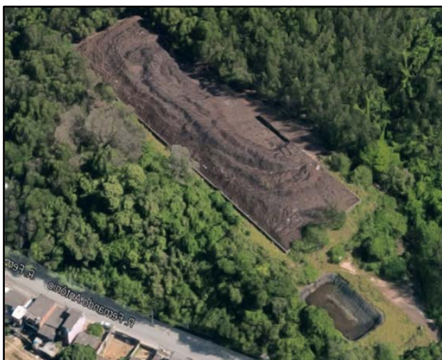
Figura 1. Planta del depósito antes de las obras.
