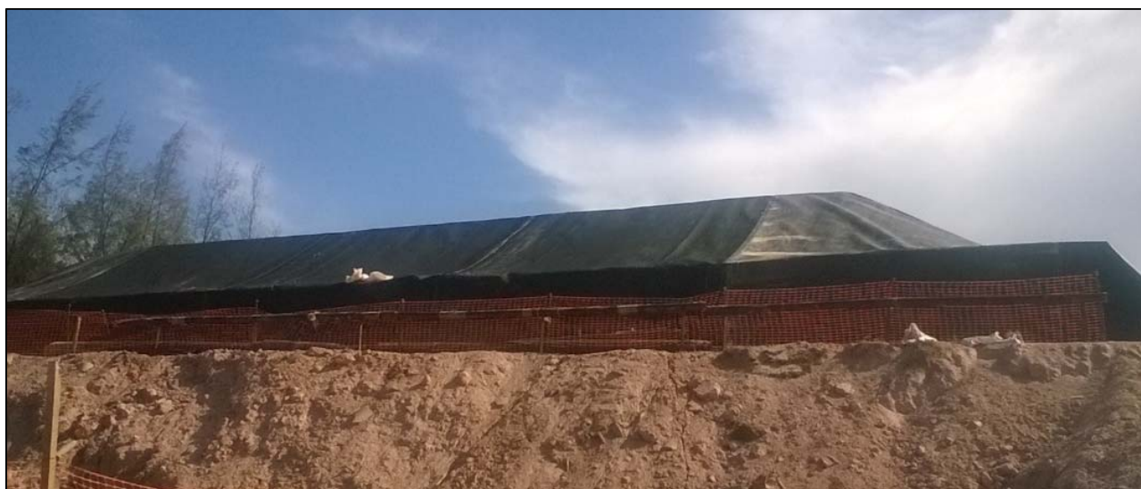
Figura 12. Depósito completamente cerrado e impermeabilizado
