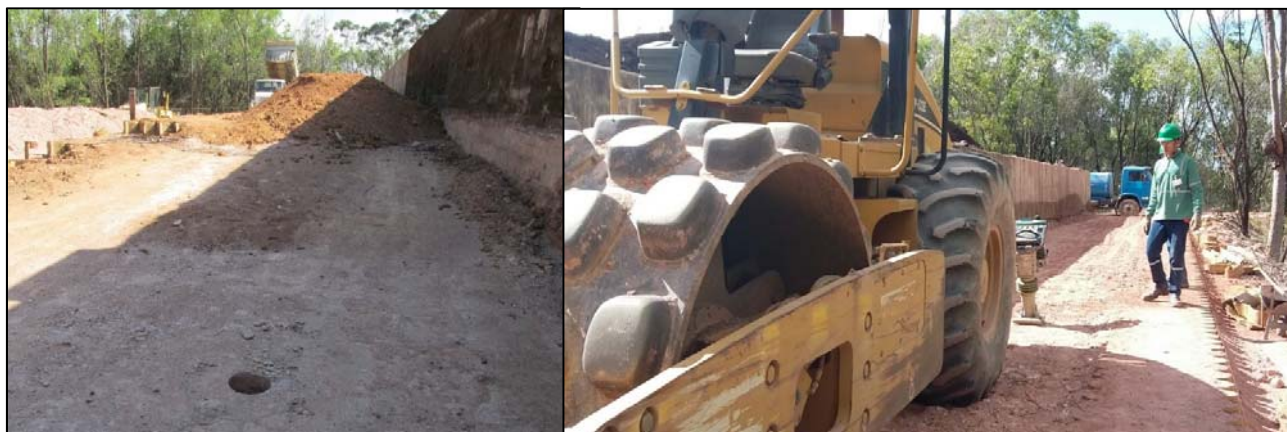
Figura 9. (a) Ensayo de compactación en la fundación del muro (b) Equipos utilizados para la compactación.
