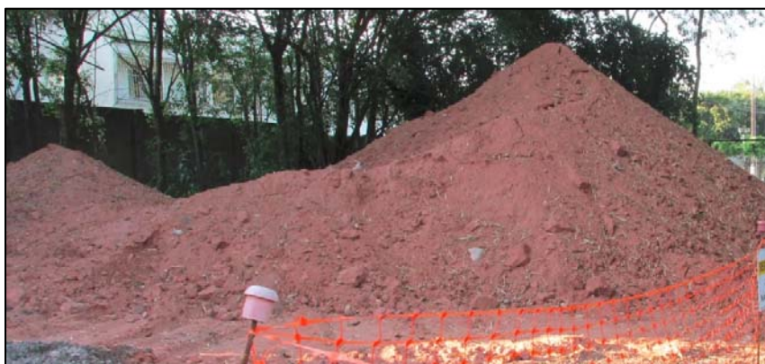
Figura 6. Suelo arcilloso utilizado para construcción del muro de suelo reforzado.
