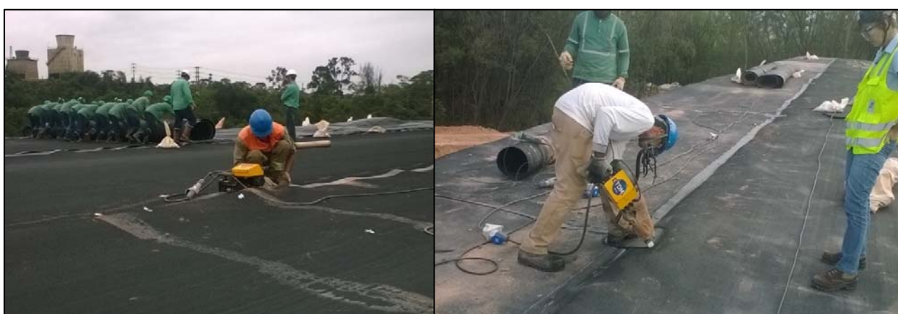
Figura 11. Proceso de instalación de la geomembrana sobre el depósito de residuos.
