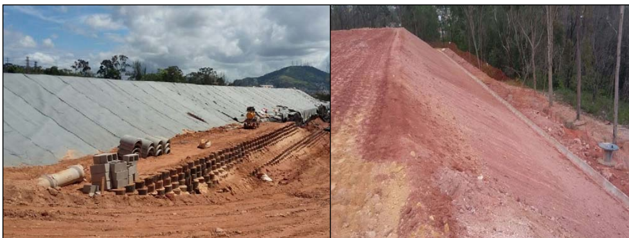
Figura 13. (a) Capa de geocompuesto drenante instalado (b) Suelo de cobertura ya instalado.
