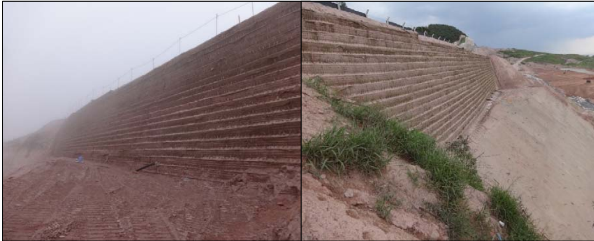
Figura 10 – Muros de suelo reforzado con geosintéticos y fachada en módulos metálicos después de la construcción (sin vegetación)
