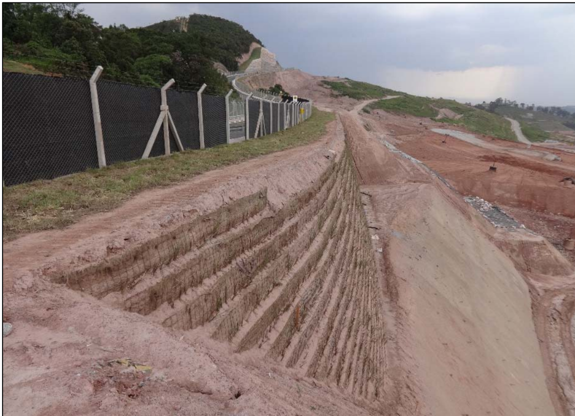
Figura 11 - Muro de suelo reforzado en proceso de vegetación y ya en funcionamiento.
