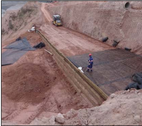
Figura 5 – Posicionamiento de los refuerzos
