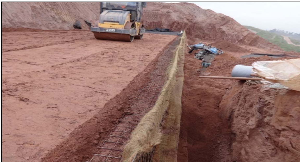
Figura 7 - Módulos y refuerzos posicionados y compactación del relleno sobre las geomallas.
