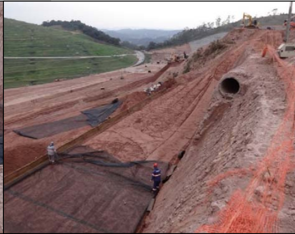
Figura 6 – Detalle del tubo pasando por atrás del muro
